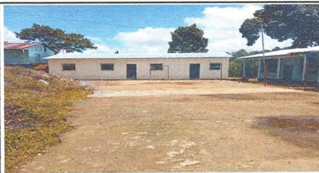
Foto 3: Finalización de repello aula módulo 3.
