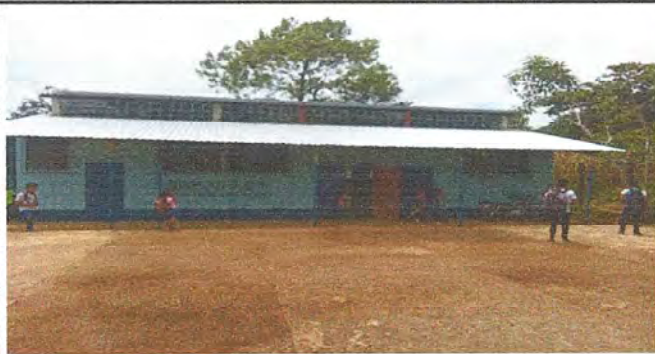
Foto1:Finalización de colocación de techo módulo 1.
