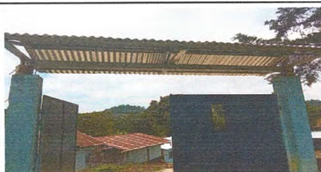
Foto 10: Finalización, instalación de estructura y cambio de techo, portón de entrada módulo 7.
