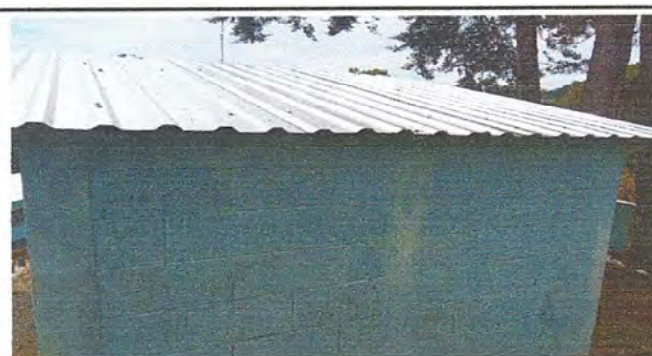
Foto 9: Cambio de techo de letrina para nivel primaria módulo 6.
