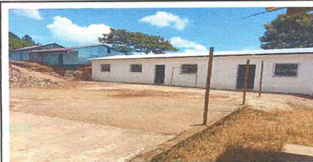
Foto 5: Finalización de repello de aula módulo 3.
