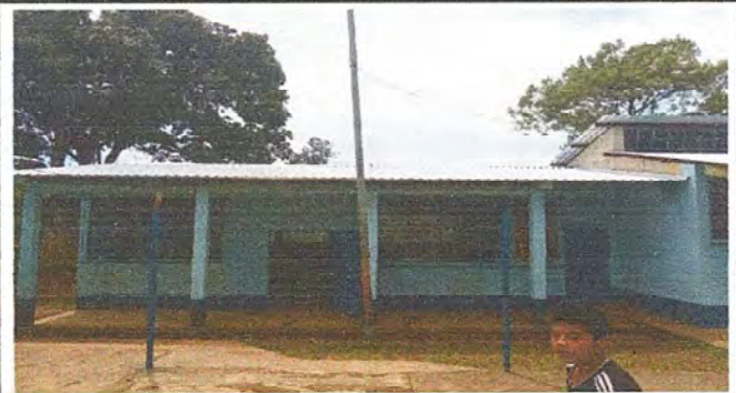
Foto 2: Finalización de instalación de estructura y techo módulo 2.
