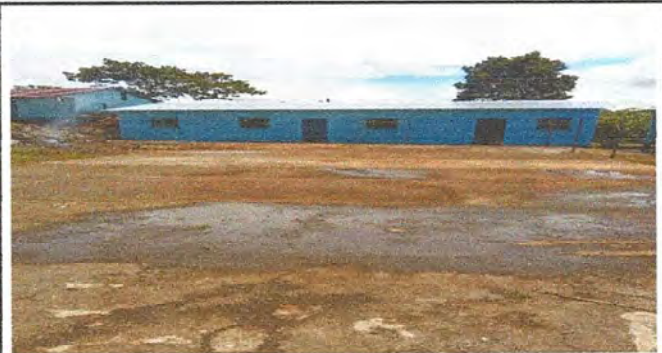
Foto 4: Finalización de entechado módulo 3.
