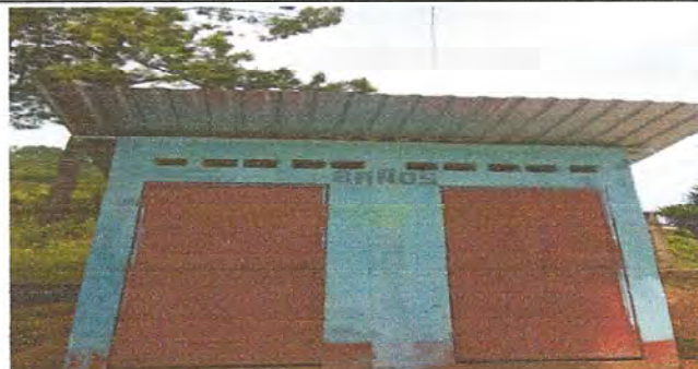
Foto 8: Finalización de cambio de estructura y techo de letrina del nivel primario módulo 5.
