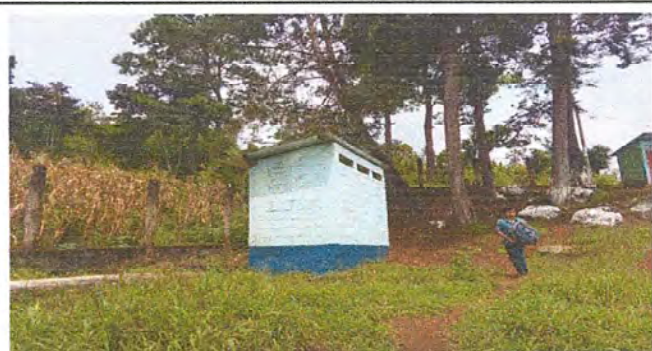
Foto 7: Finalización de cambio de estructura y techo de letrina del nivel preprimaria módulo 4.
