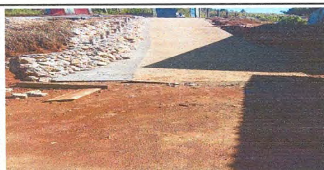
Foto 11: Finalización de construcción de muro perimetral módulo 8.
