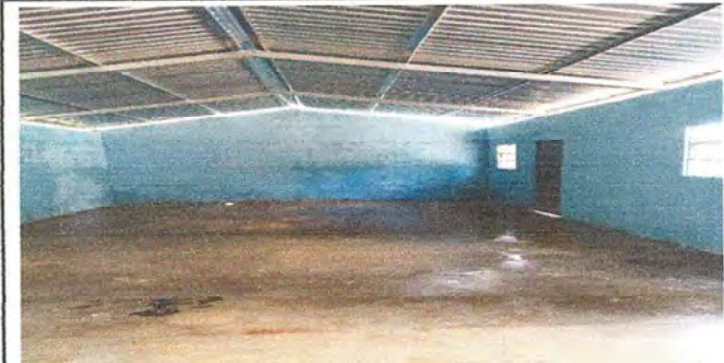
Foto 6: Finalización de fundición de aula módulo 3.
